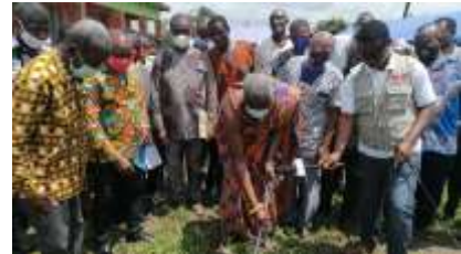
Feierlicher Spatenstich Sept.2020
