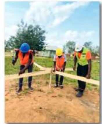
Endlich geht es los, der Bau des Jugendzentrums im ghanaischen Mafi Dadoboe
