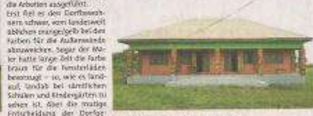
Der Kindergarten nach dem Anstrich.
